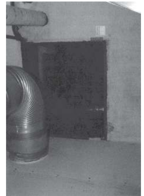
De doorgang in de uerwarmingsruimte (Foto: Steven van Loo)
